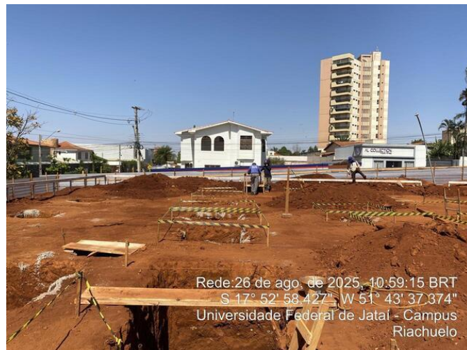
Vala da sapata sem forma
