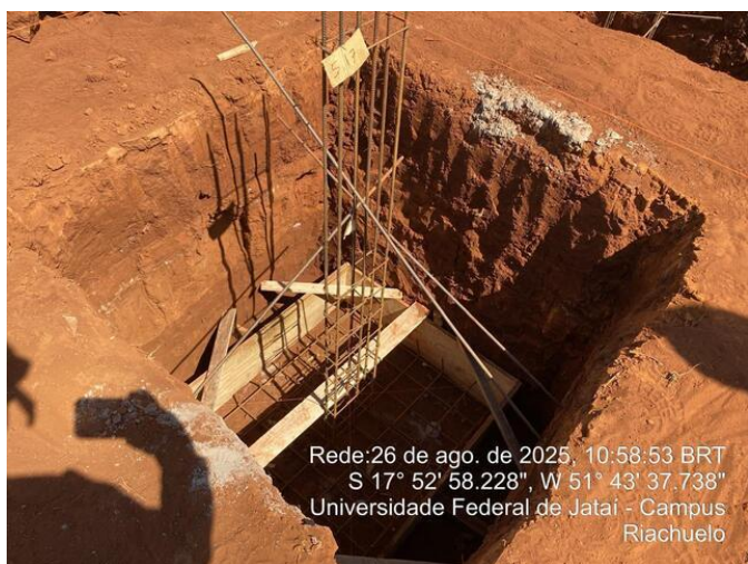
Sapata sem concreto
