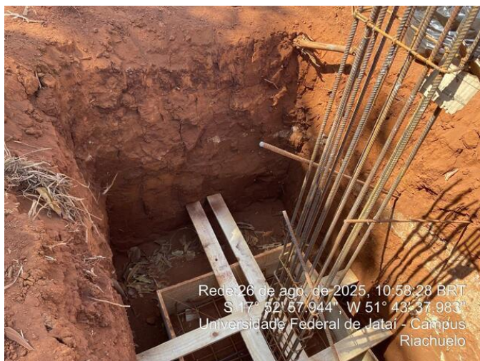
Sapata sem concreto
