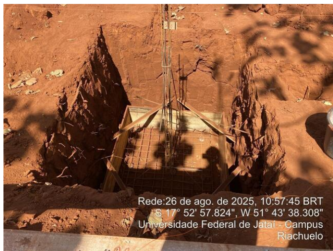
Sapata sem concreto
