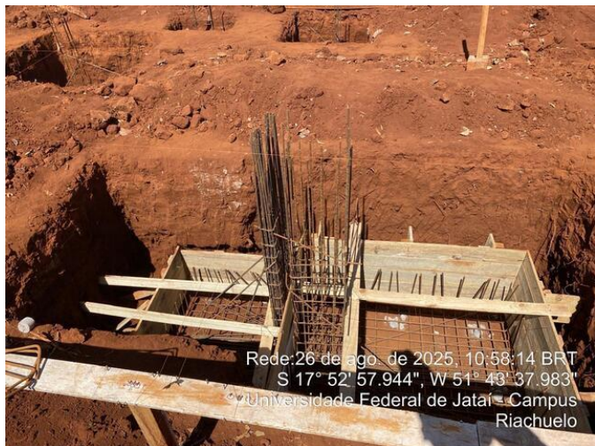
Sapata sem concreto
