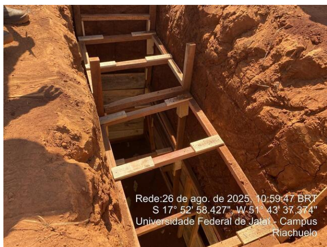
Sapata sem concreto
